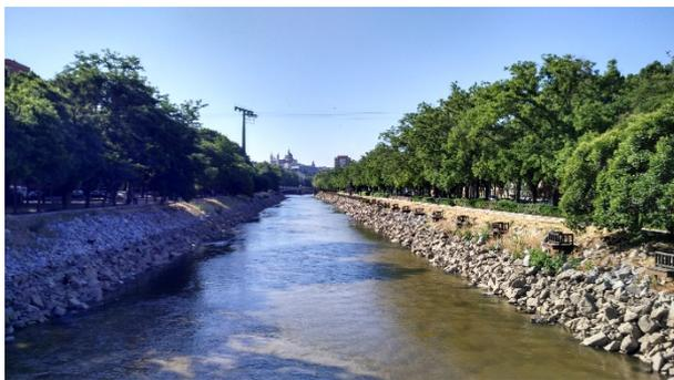
Vistas del entorno del puente de la Reina Victoria (agosto 2016): tramo inicial de escollera (izquierda) y tramo central de muros de bloques de granito (derecha)
